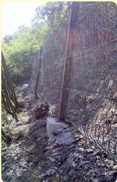
“Grazie” al distacco di un ammasso roccioso terminato senza danni sulla strada di Montepiano, è stato possibile accedere ad un contributo per posare altri 50 metri di rete paramassi.
